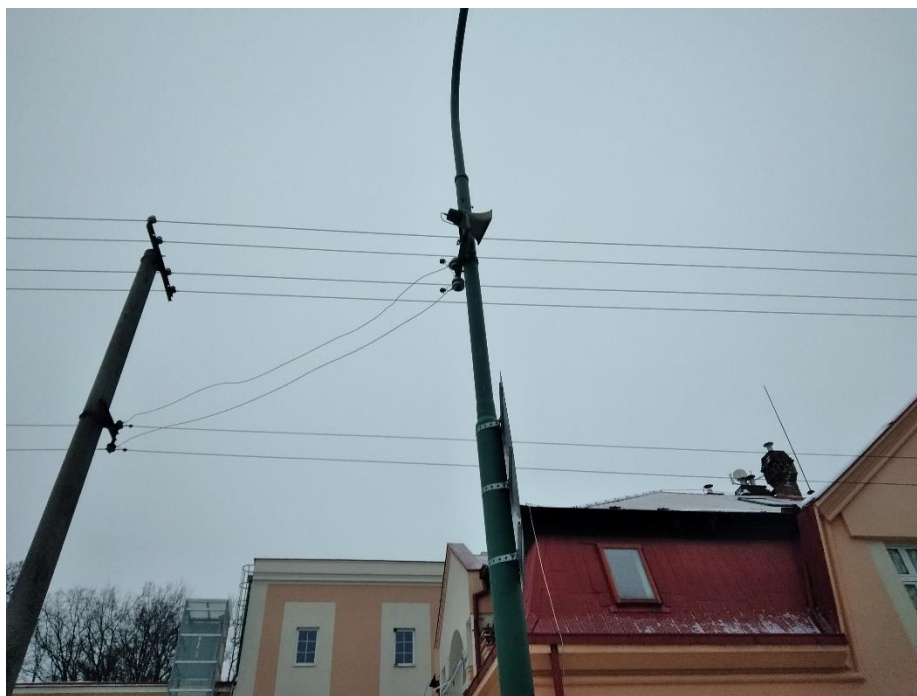
Obrázek 8: Amplion u mlýna využívající drátovou technologii a jako opěrný systém stožár lampy veřejného osvětlení (foto autor, přelom 2020/2021)
