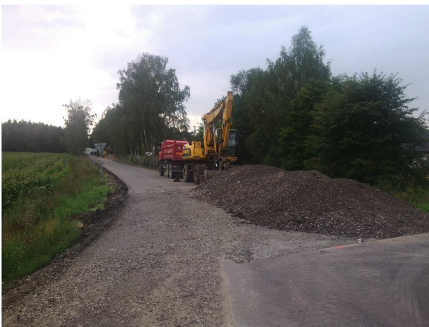
Obrázek 4: Stav prací na komunikaci Břehy – Semín k 25. 8. (autor)
