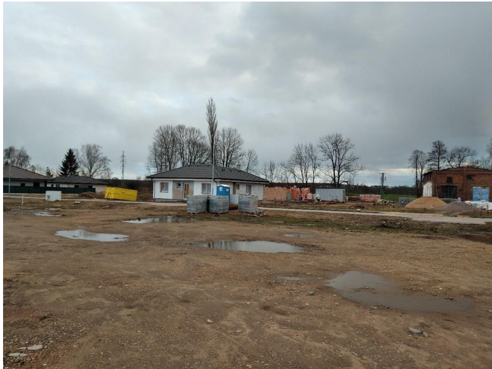
Obrázek 8: Staveniště nových rodinných domů v areálu bývalé pily (stav na počátku roku 2020, autor)
