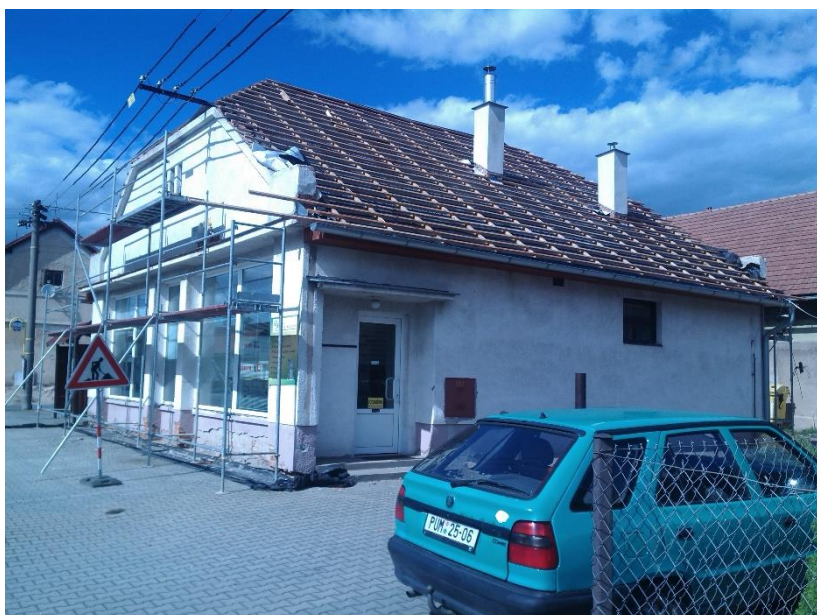
Obrázek 7: Záběr na budovu budoucí knihovny v průběhu prací. Střecha čeká na novou krytinu. U čela budovy vyrostlo lešení (foto autor, 1. 7.)
