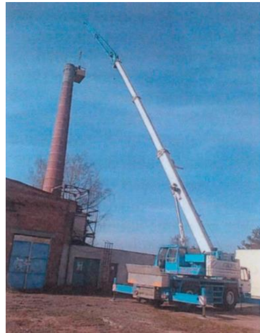
Obrázek 4: Pěkná podívaná, umístování základny pro založení hnízdiště čápa (zdroj: Břežan 1/2017)
