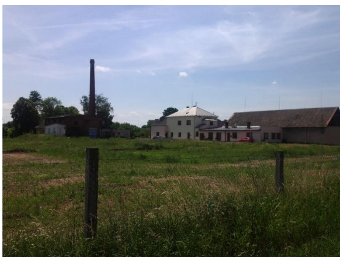
Obrázek 6: Stav obytného objektu a části kupovaného areálu (objekty po dřevozpracujícím průmyslu s komínem) k 15. 6. (foto autor)
