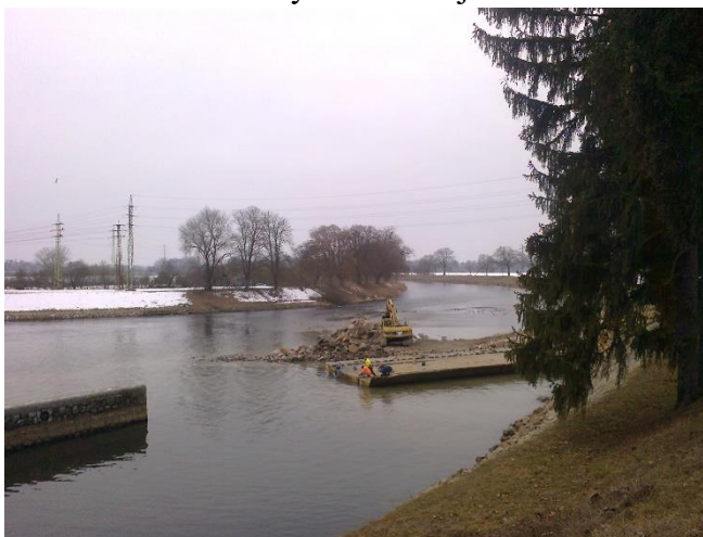
Obrázek 31: Přísun techniky a materiálu v podobě velkých balvanů zajišťoval pontonový most (autor, 8. 2.)
