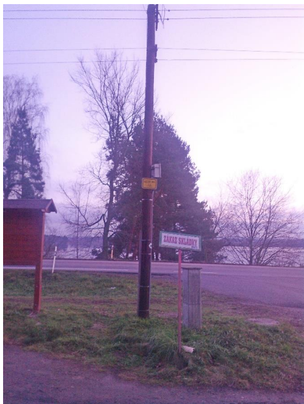
Obrázek 1: Poloha staršího typu dřevěného sloupu bez betonové patky, nosiče drátů vysokého napětí, u restaurace Cikánka – okénko do nedávné historie (autor, 27. 12.)
