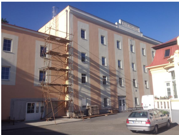
Obrázek 3: Pohled na staveniště vnějšího vyhlídkového výtahu (foto autor, 31. 8. 2016)
