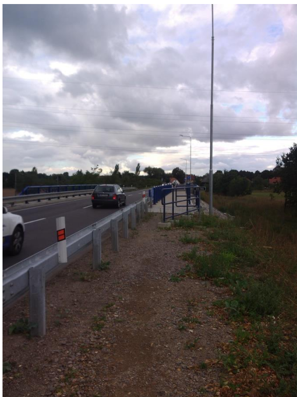
Obrázek 11: Pohled na nový most a lávku (oblast Střídeň), (5. 9. 2016, autor)
