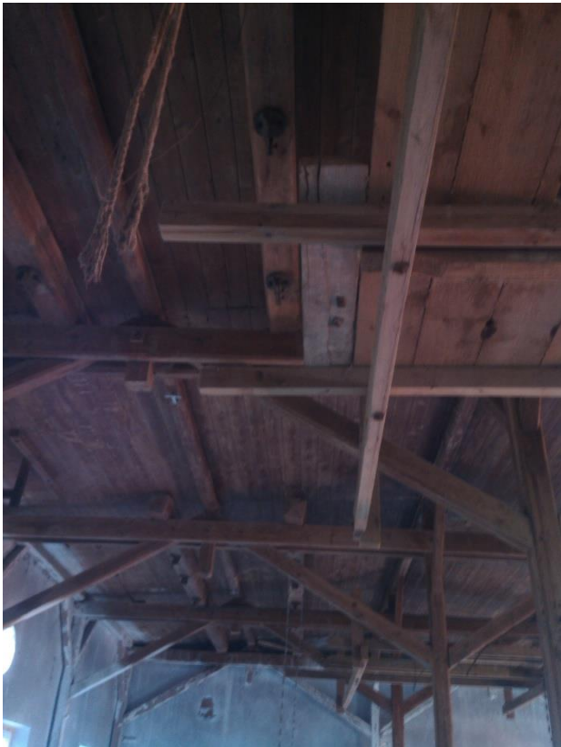
Obrázek 7: Pohled na střešní konstrukci zespodu (foto autor, 31. 8. 2016)
