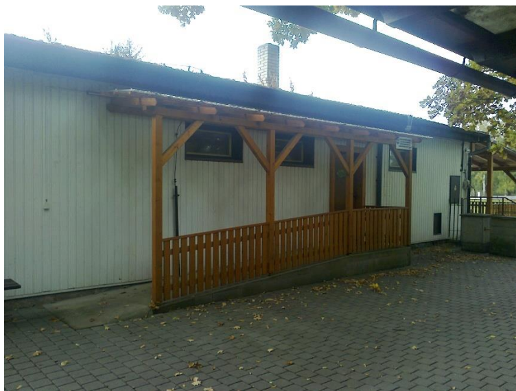
Obrázek 14: Není tomu tak dávno co se WC a sprchy Sokolovny zpřístupnily přímým vstupem od restaurace. Do této doby se do tohoto oddělení chodilo ze sálu. Prostor byl navíc zastřešen a ohraničen zábradlím. (foto autor, polovina října)
