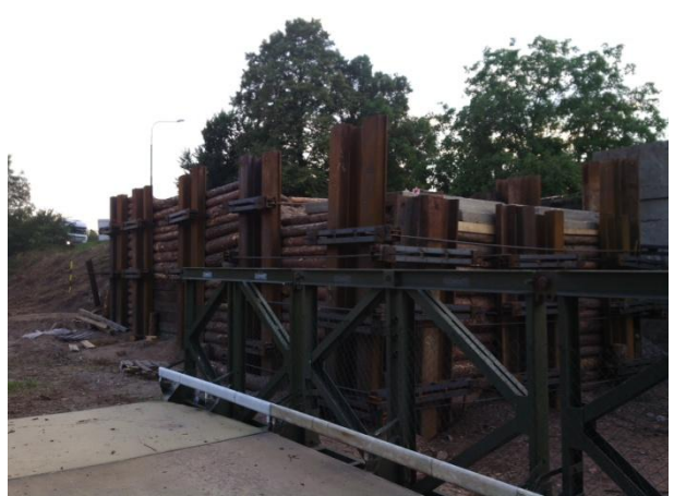
Obrázek 14: Pohled na bednění nově budovaného mostu
