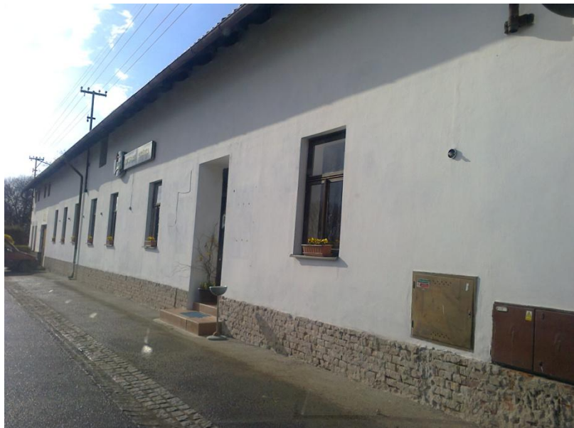
Obrázek 7: Obnažená část základového zdiva hostince "Na cikánci" (6. 4. 2015, autor)
