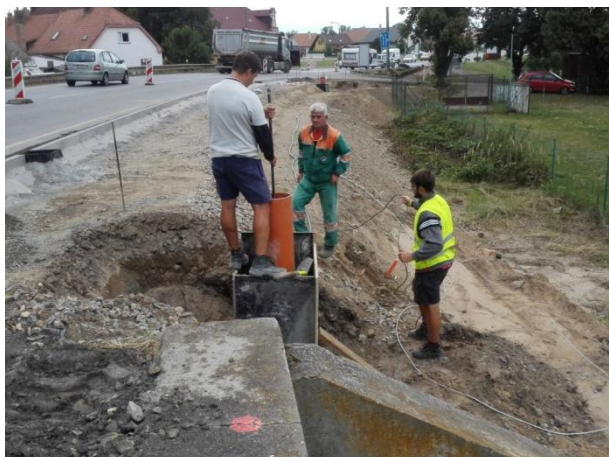
Obrázek 17: Práce v přímém přenosu, buduje se základ osvětlení. Snímek pořídil člen firmy Chládek a Tintěra a je z jejich webu.
