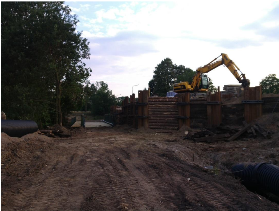
Obrázek 16: Na snímku je provizorium a budovaná spojnice
