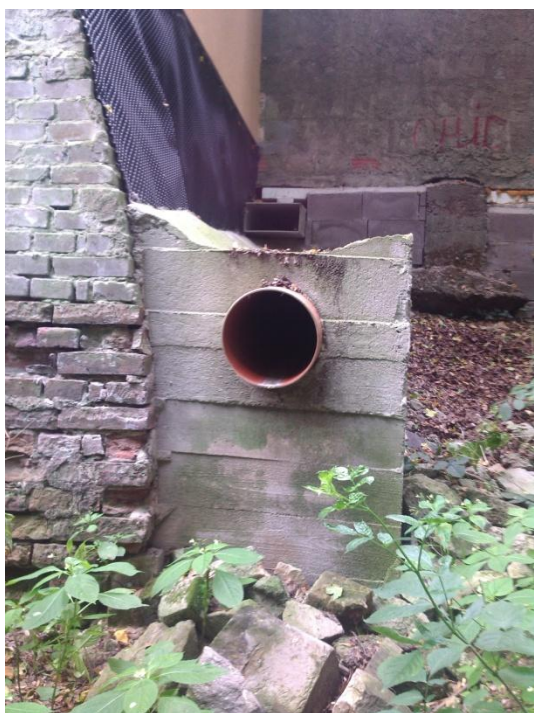
Obrázek 4: Pohled do ústí odvodňovacích soustav, severní strana (30. 7. 2015)
