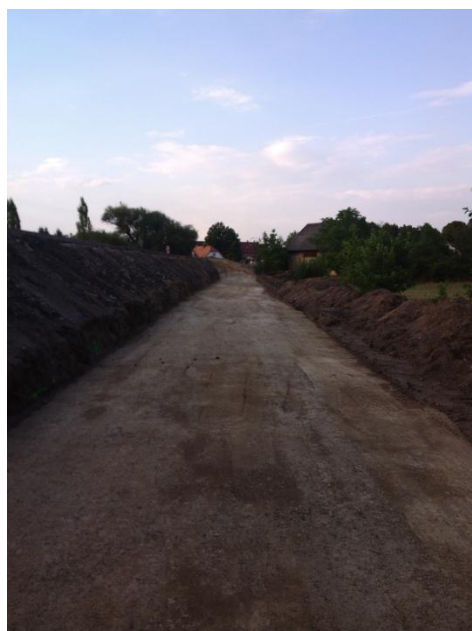
Obrázek 13: Pohled na budovanou stezku bez povrchové úpravy od Střídně
