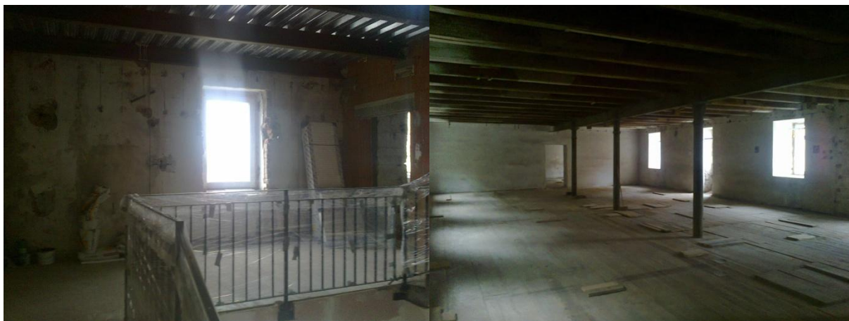
Obrázek 11: Rozdělané práce na schodišti v prvním patře mlýna (15. 10. 2014)
