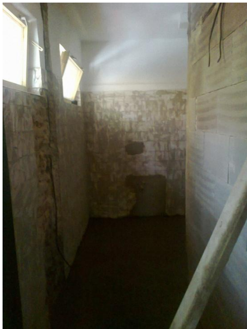
Obrázek 1: Průběh prací na ženských WC v objektu Sokolovny (konec května)
