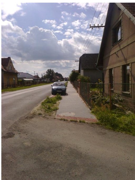
Obrázek 3: Pohled na dokončený chodník v ulici Bahníkova (15. 8. 2014)
