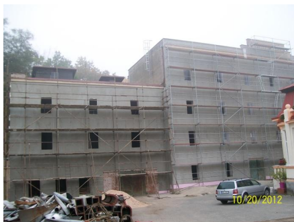
Obrázek 9: Ke konci října byla už přední část plochy mlýna zateplena
