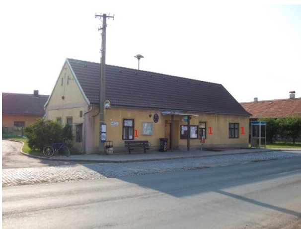
Obrázek 1: Současný stav Obecního úřadu, 1 - dobře jsou patrná "nízko posazená okna" (29. 6. 2012)
