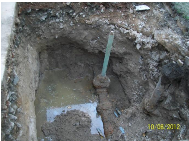
Obrázek 18: Vodovodní síť za desítky let se značně opotřebovala
