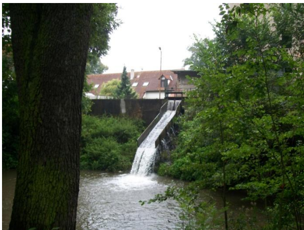
Obrázek 46: Proudění vody přes jalové stavidlo po dřevěné jalové troubě po vydatných srážkách (1. 9. 2012)
