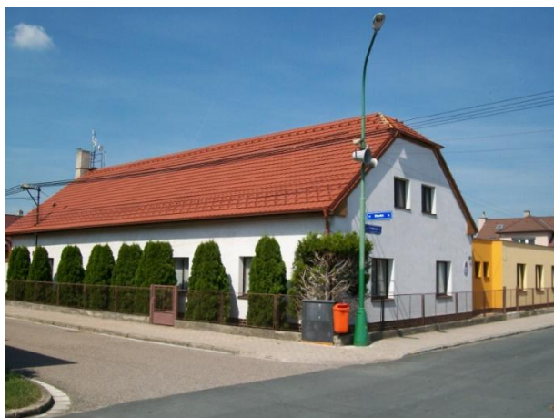
Obrázek 24: ... a již téměř dokončená střecha na MŠ (stav k 18. 8. 2012)
