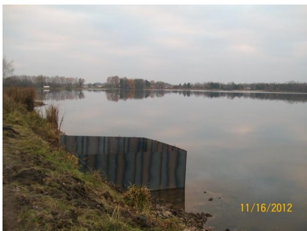
Obrázek 45: Stav zahajovacích prací k vybudování stavidla k novému rybníku v severozápadní části obce Lohenice
