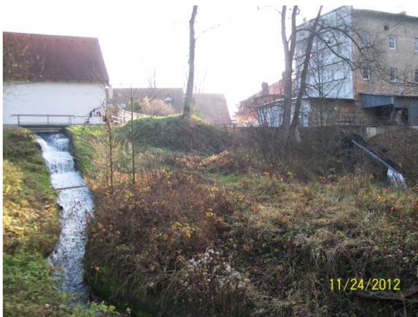
Obrázek 50: V druhé polovině listopadu bylo dostatek srážek, jako "improvizované měřidlo" srážek lze považovat jalové stavidlo a přepad na Výrově
