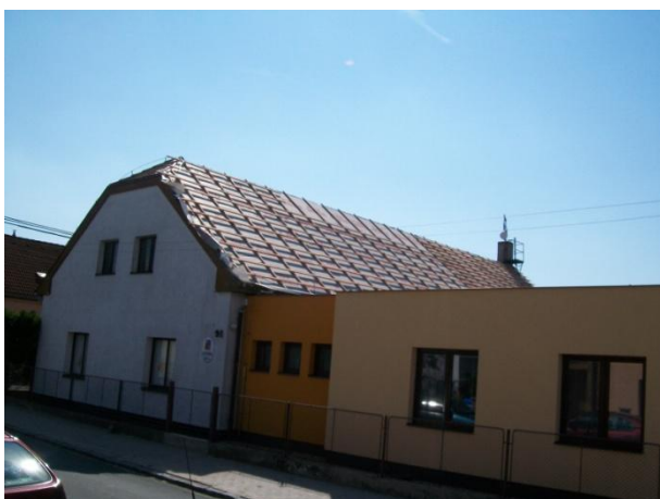
Obrázek 22: Stav prací ke 2. 8. 2012 na severní straně střechy MŠ
