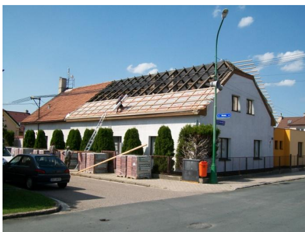
Obrázek 19: Stav prací k 6. 8. 2012 na jižní straně střechy MŠ
