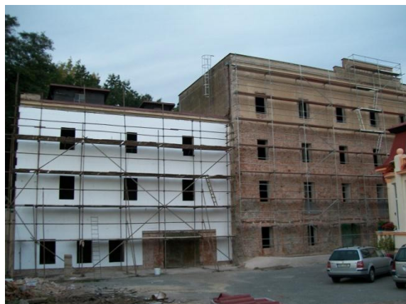
Obrázek 7: Po odstranění staré fasády a stabilizaci přišlo na řadu zateplení, nejdříve bylo opatřováno polystyrénem západní křídlo mlýna (Stav prací k 26. 9. 2012)
