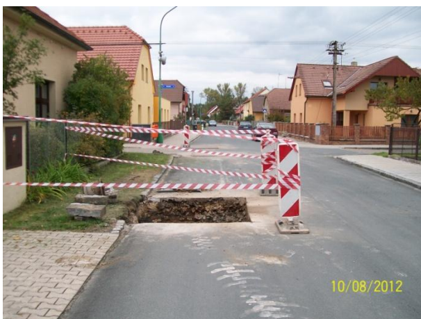
Obrázek 17: Vymezený prostor oprav vodovodní sítě v ulici Zákoutí
