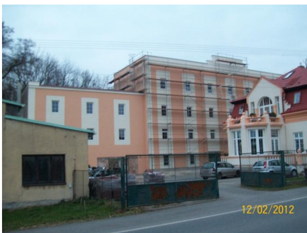
Obrázek 10: Fasáda na přední straně mlýna je už kompletně hotová .... zbývá jen odstranit lešení.
