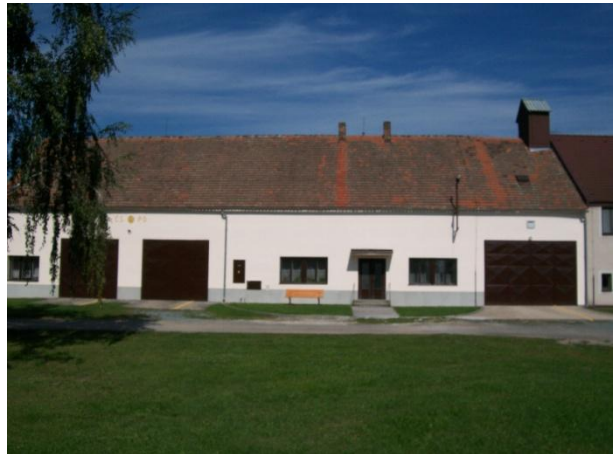
Obrázek 15: Již dokončená fasáda na hasičské zbrojnici (stav objektu ke 2. 8. 2012) – čelní pohled
