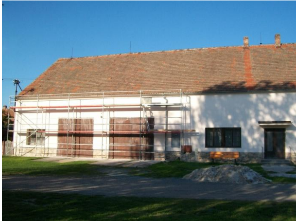
Obrázek 16: Stav objektu hasičské zbrojnice k 23. 7. 2012 – čelní pohled
