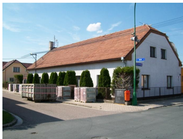
Obrázek 20: Přistavený potřebný materiál na opravu střechy u jižní hranice školního pozemku - stav k 2. 8. 2012
