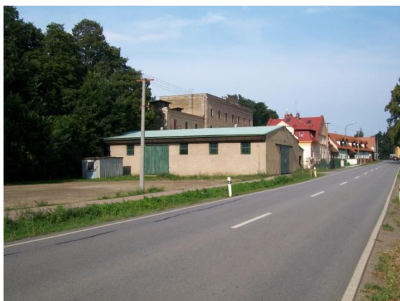
Obrázek 11: Pohled na západní a jižní část zájmového objektu (Stav k 28. 7. 2012)
