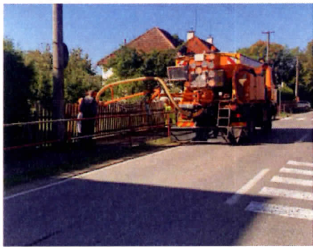
Asfaltování povrchů v obci
