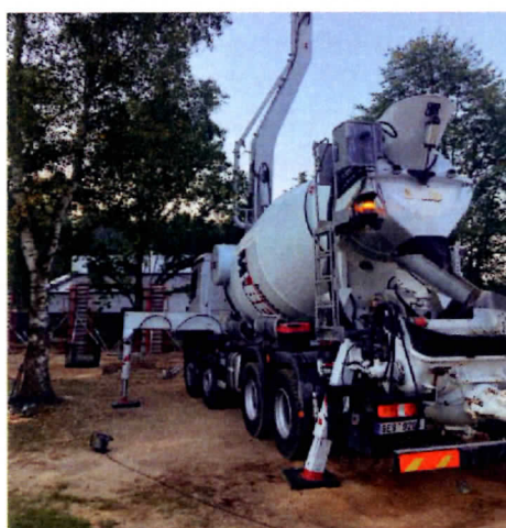
Betonování základů učebny
