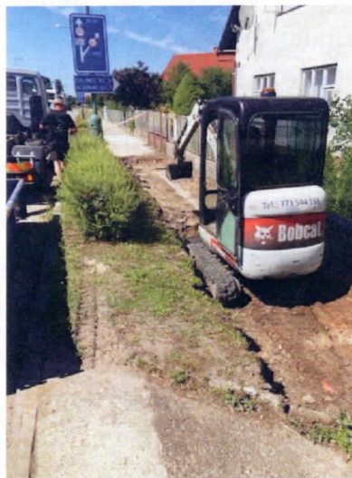
Práce na chodníku
