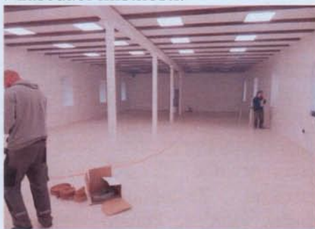
Firma Strnad pokládá krytinu ve 3. NP
