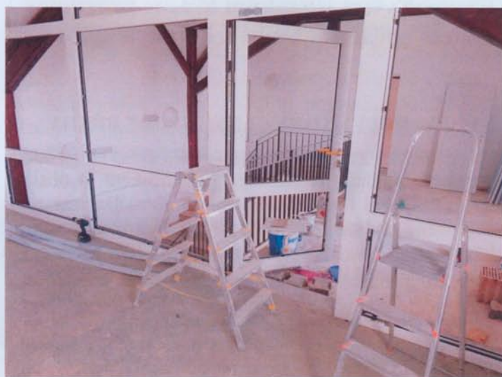
Montáž prosklené stěny
