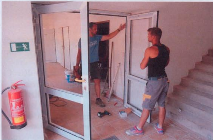
Montáž dvoukřídlých prosklených dveří v přízemí mlýnu
