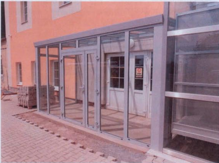
Vstupní prosklené atrium tvoří i zádveří proskleného výtahu
