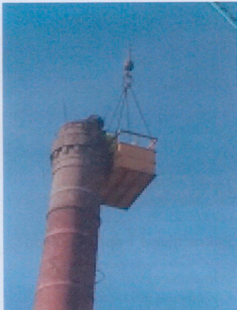
Instalace základny hnízda na komín Petr Morávek
