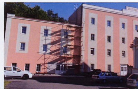
Místo instalace výtahu s lešením
