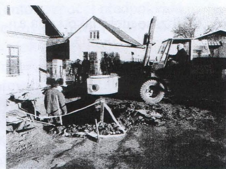
Osazování přípojky kanalizace pro čp. 97
