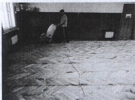
Oprava parketové podlahy
