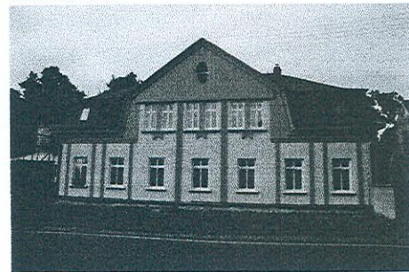
Opravená fasáda Foto Petr Morávek
