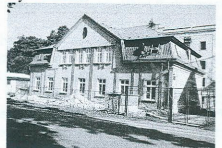
Po výměně oken
