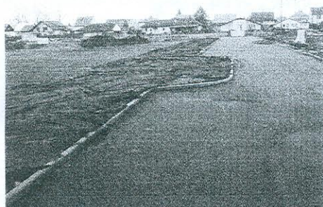
Nová ulice těsně před dokončením
