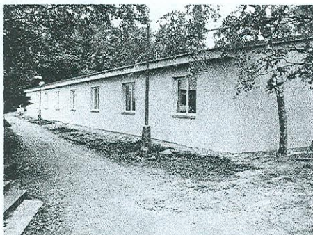
Ubytovna ještě před nátěrem fasády
