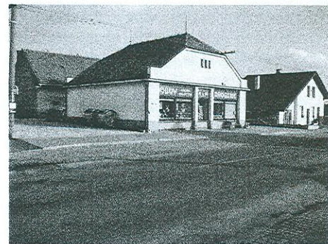
Prostor u prodejny po úklidu a úpravě ploch
