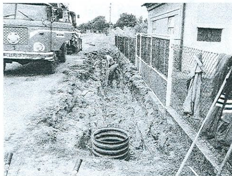
Výkopové práce před RD čp. 106 ...
