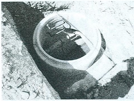
Nová šachta na kmenovém potrubí
